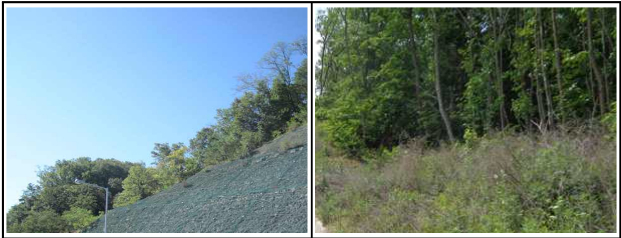
【그림 60.3.1】 상부자연사면 전경
