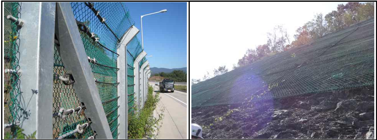
【그림 60.3.4】 보호/보강시설 전경
