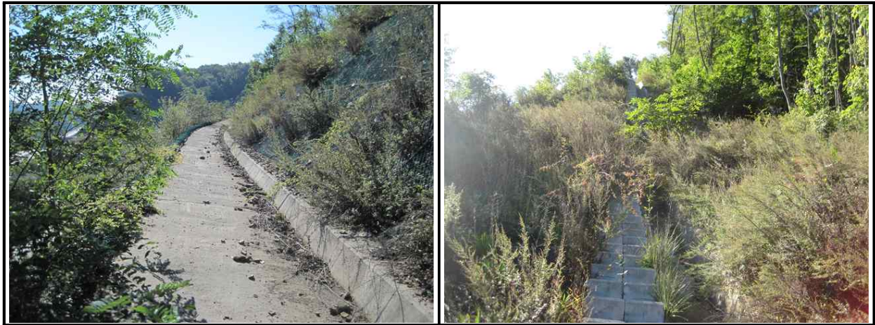
【그림 60.3.3】 배수시설 전경
