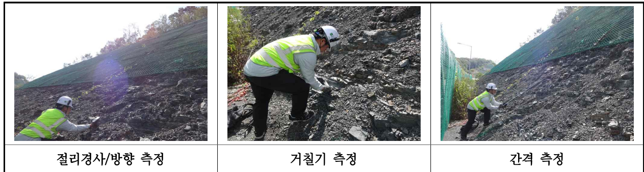
【그림 60.3.5】 불연속면 측정 현황
